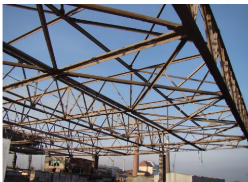
Рисунок 5 – Поперечные горизонтальные и вертикальные связи по оси 1 (вид в сторону ряда Б)
