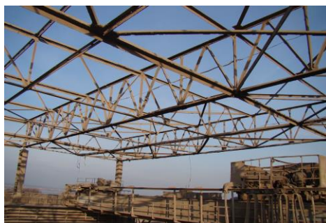
Рисунок 3 – Стропильные фермы по осям 1 и 2
