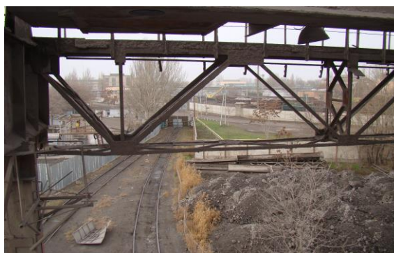
Рисунок 6 – Фермы под поперечный проходной мостик по оси 6 (вид со стороны ряда Б) а) горизонтальная ферма; б) вертикальные фермы
