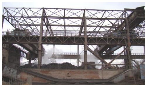
Рисунок 7 – Часть сохранившейся кирпичной стены вдоль ряда Б (оси 1–4)
