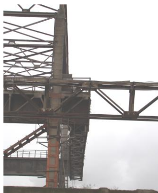
Рисунок 6 – Фермы под поперечный проходной мостик по оси 6 (вид со стороны ряда Б) а) горизонтальная ферма; б) вертикальные фермы
